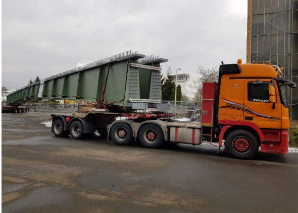
© Hessen Mobil (Anlieferung von zwei Trägern im Betonwerk)
