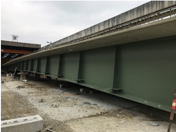
Fertiggestellter und betonierter Verbundfertigteilträger im Betonwerk OSW Nidda
